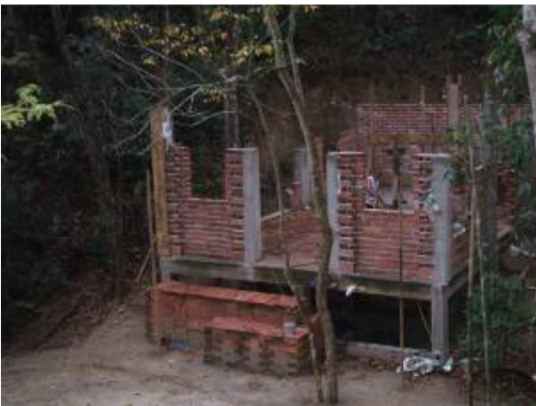
Construção da Igreja – Niterói, RJ
